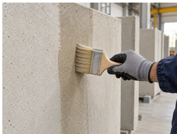
Application d'un fixateur incolore sur un fond minéral poreux.
