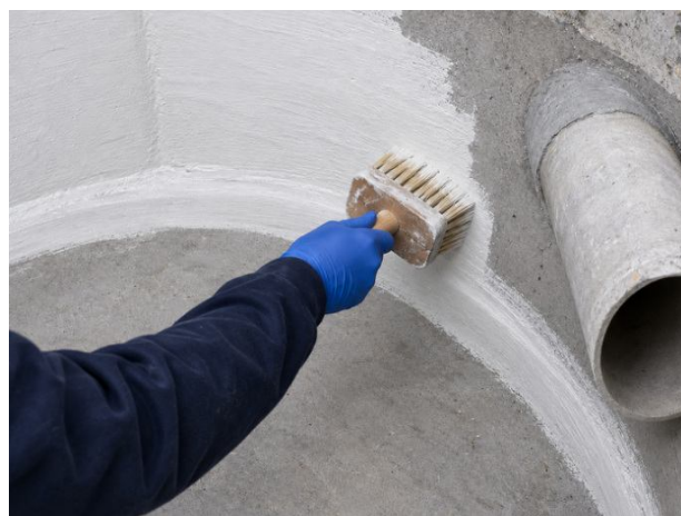
Protection d'une pièce béton à géométrie courbe.
