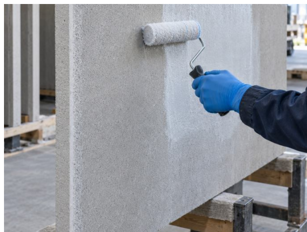
Préparation de panneaux minéraux de façade.
