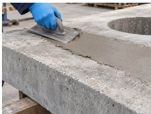
Ragréage de défauts sur une pièce béton.
