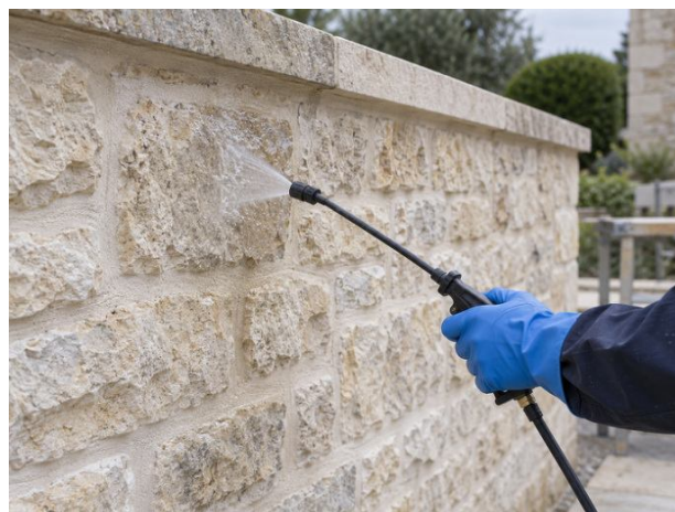
Traitement par pulvérisation d'un parement pierre préparé.
