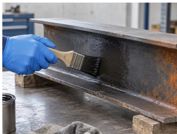
Traitement de rouille résiduelle sur acier préparé.
