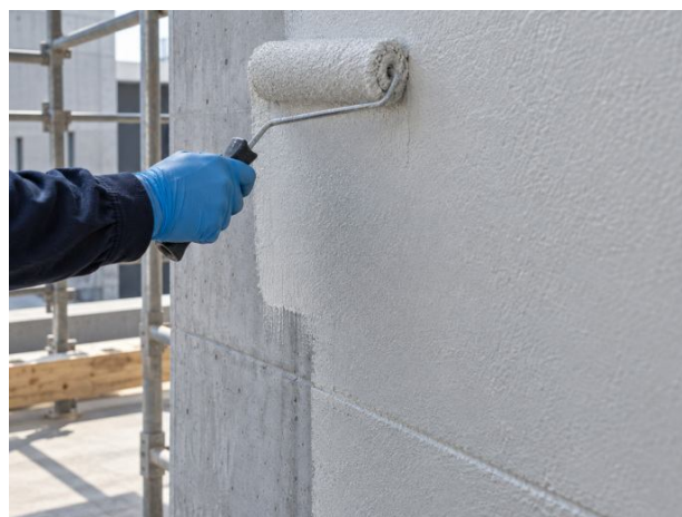
Protection de parois béton exposées.
