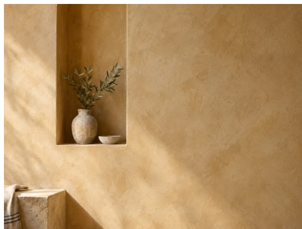
Badigeon à la chaux sur parement minéral.
