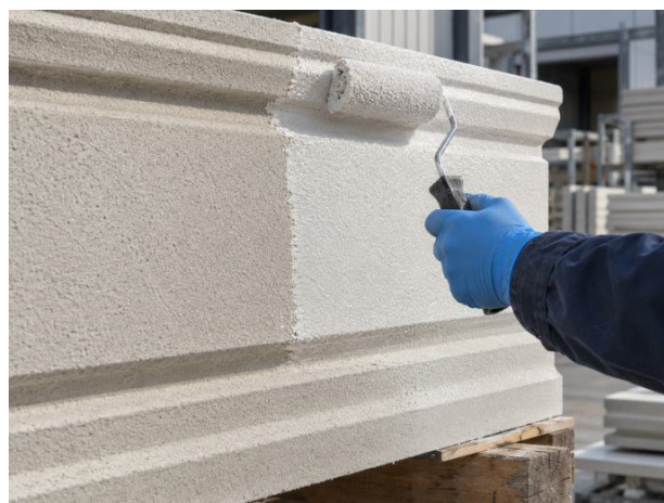
Finition d'éléments minéraux de façade.
