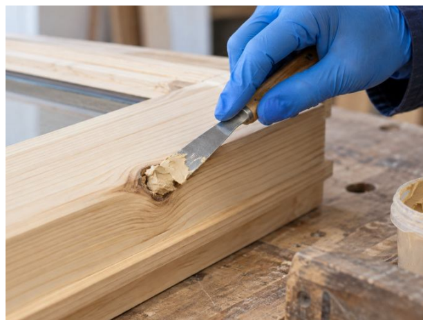
Reprise d'un défaut sur une menuiserie bois.
