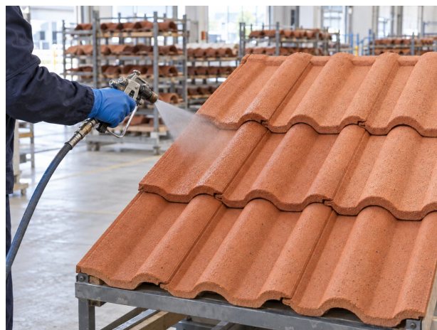
Application d'un densificateur incolore sur des tuiles en terre cuite friables.
