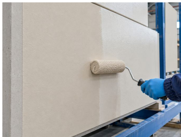
Peinture de parements fabriqués en atelier.
