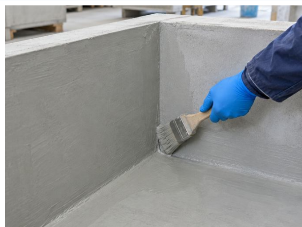
Protection de parois de pièces béton.
