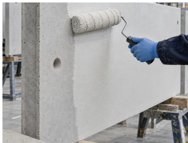
Mise en peinture de panneaux béton préparés.
