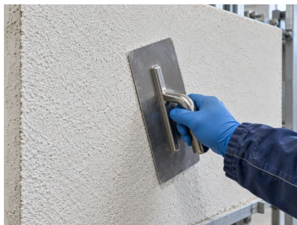
Préparation d'un fond pour finition minérale.
