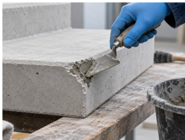
Reprise d'un éclat sur escalier préfabriqué.
