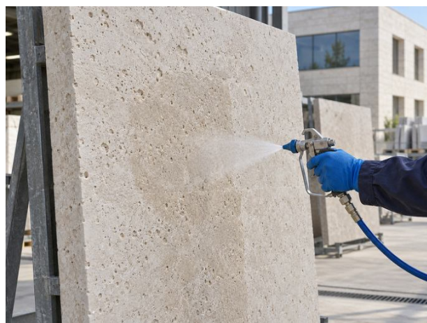
Pulvérisation d'un traitement photocatalytique sur pierre de façade.
