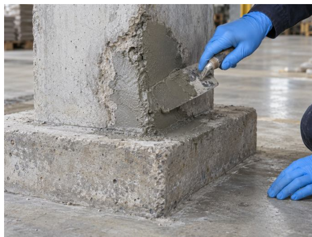
Réparation localisée d'un élément béton.
