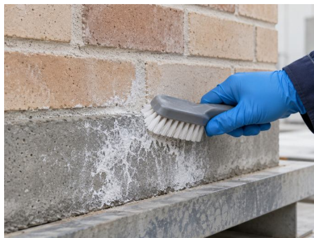
Préparation de surfaces minérales avec dépôts.
