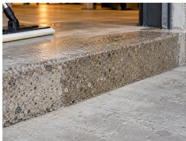
Primaire pénétrant sur support minéral préparé.
