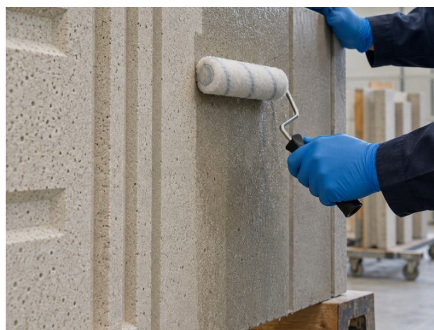
Régulation d'un fond avant protection anti-graffiti.
