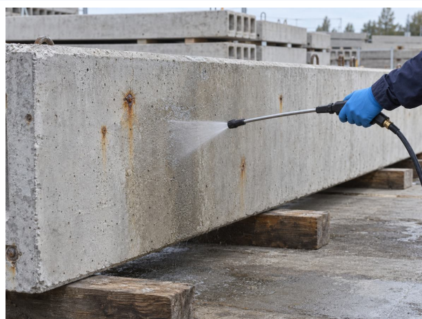
Pulvérisation du traitement MFP sur un élément préfabriqué marqué par la corrosion.
