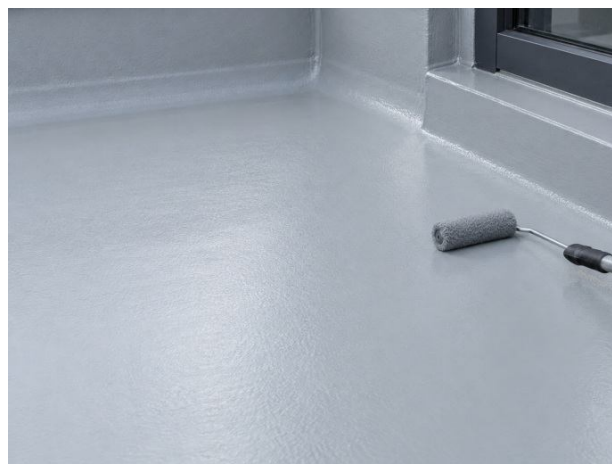
Finition de protection sur un système de membrane polyuréthane.
