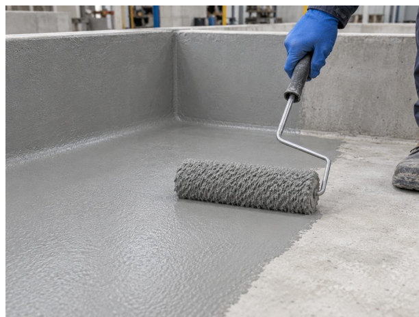
Étanchéité ciment-polymère grise appliquée au rouleau à poils longs.
