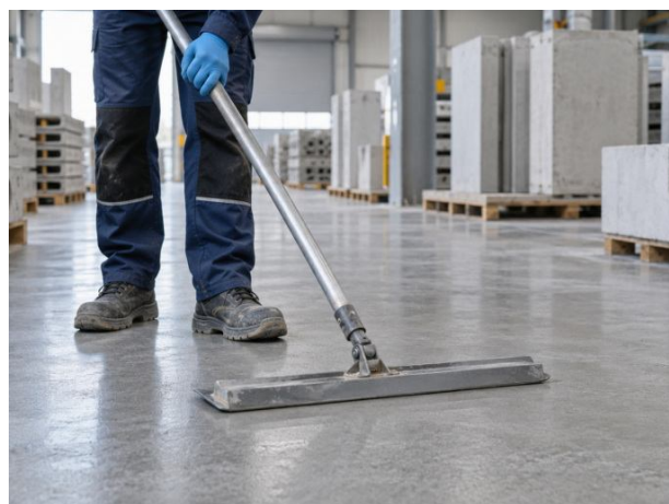
Densification de surfaces béton circulées.
