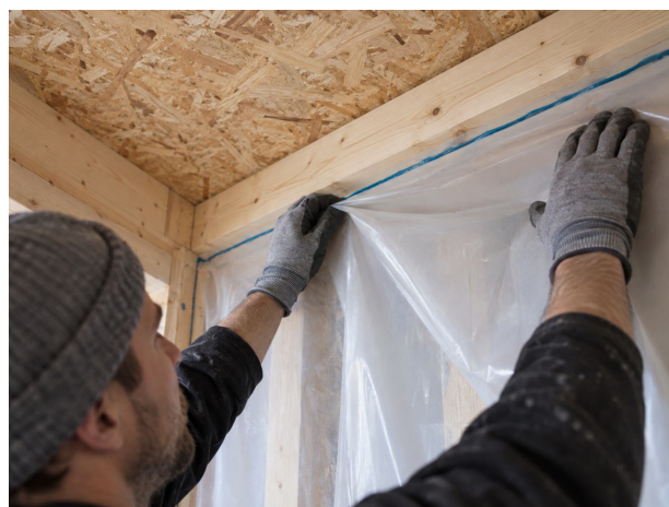
Collage d'une membrane sur l'ossature, avec réserve de mouvement.
