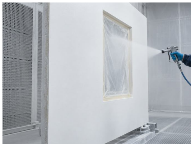
Application airless sur un panneau de module intérieur.
