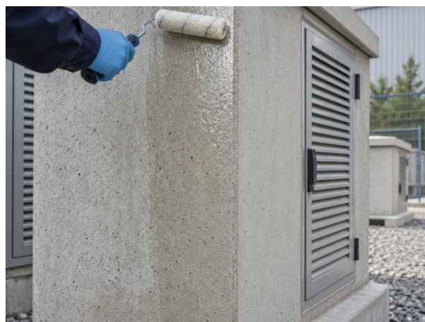
Protection anti-graffiti de coques de transformateurs.
