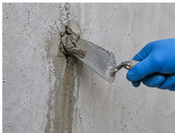
Obturation localisée d'un suintement.
