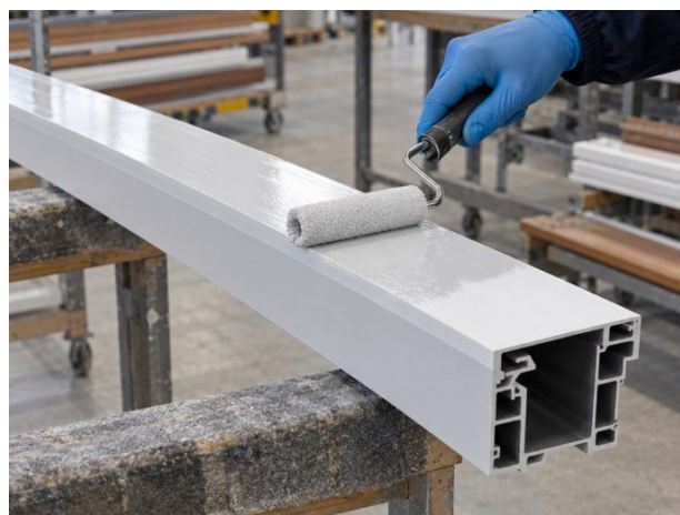
Mise en peinture de profilés multisupports.
