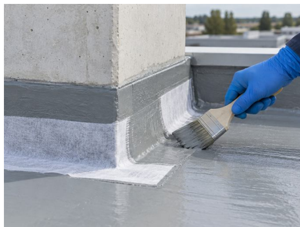
Étanchéité liquide et traitement d'un relevé.
