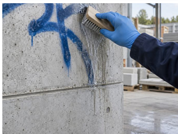
Nettoyage d'une trace de peinture sur parement.
