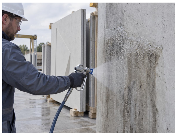
Pulvérisation airless d'un gel nettoyant sur un parement stocké dehors.
