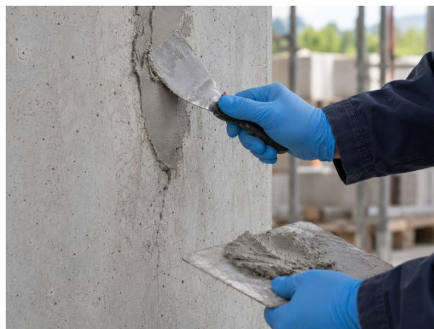
Reprise localisée d'un défaut de parement.
