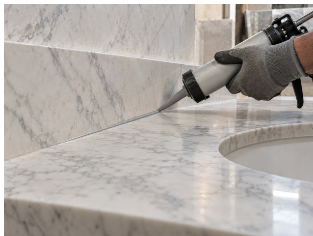
Joint discret entre un plan en marbre et sa remontée murale.
