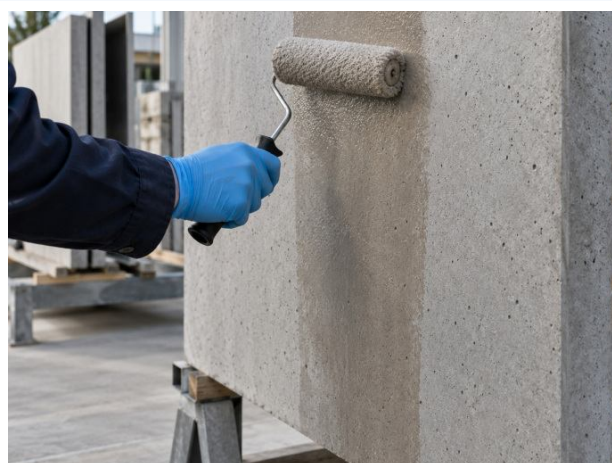
Lasure de parements de façade en béton.
