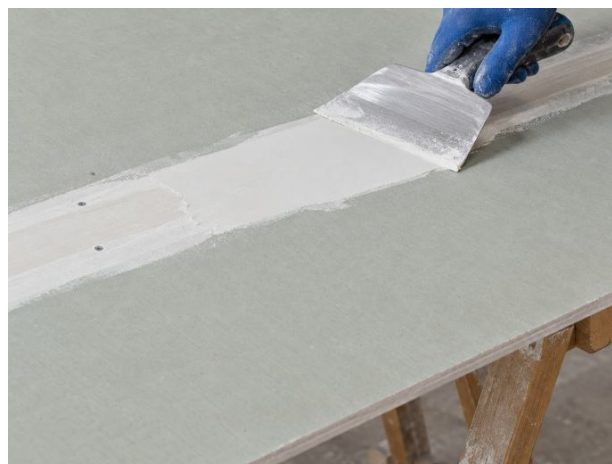
Lissage d'une reprise sur panneau intérieur avant peinture.
