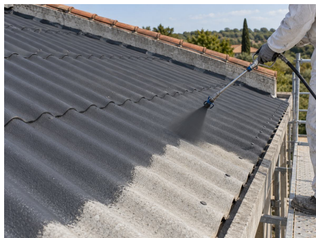
Hydrofuge coloré pulvérisé à l'airless sur couverture minérale.
