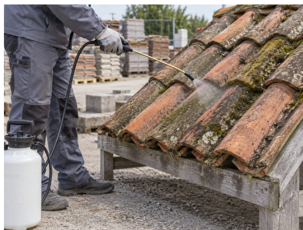
Pulvérisation manuelle sur tuiles : nettoyage progressif des verdissures.
