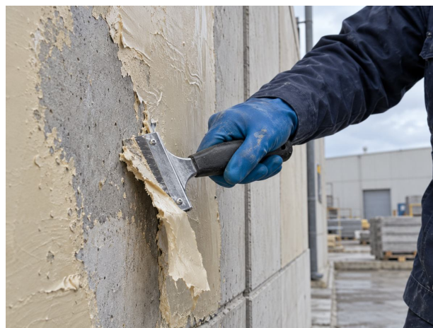
Retrait au scraper à lame du revêtement de façade ramolli.
