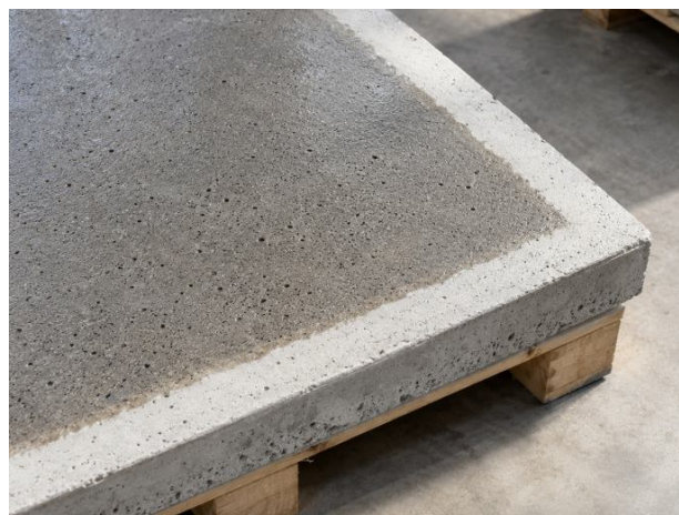
Imprégnation de béton avant système de sol.
