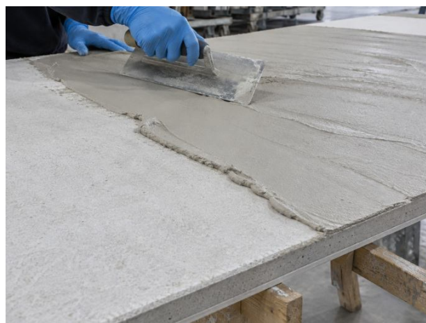
Ragréage de panneaux avant finition.
