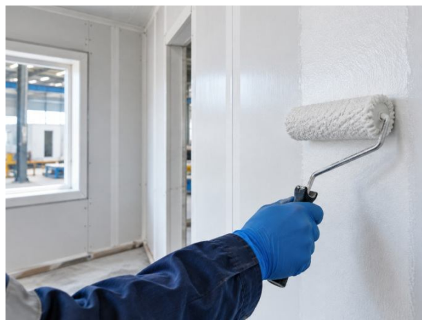
Impression des parois d'un module hors site.
