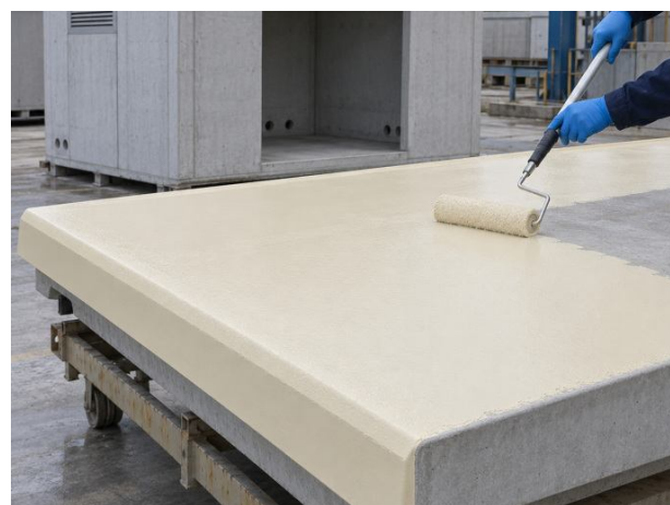
Protection d'une toiture de poste béton en atelier.
