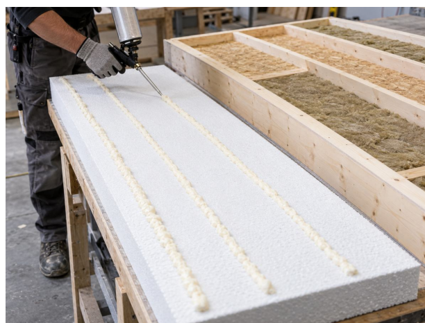
Dépose de cordons de mousse-colle sur un panneau isolant.
