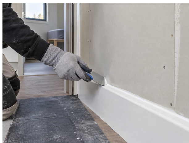
Finition du raccord entre une plinthe et une paroi de module.
