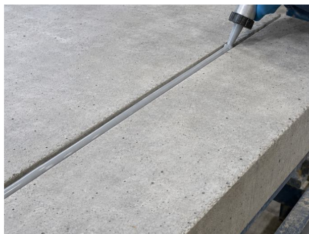
Mastic autonivelant dans un joint horizontal de pièces béton.
