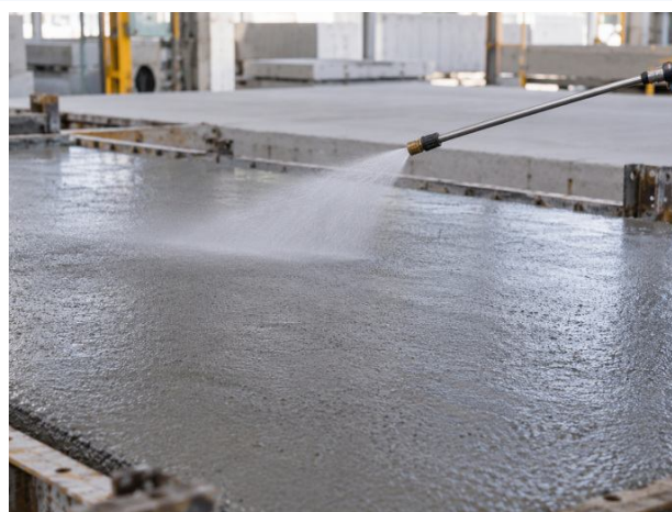
Cure après coulage d'un élément préfabriqué.
