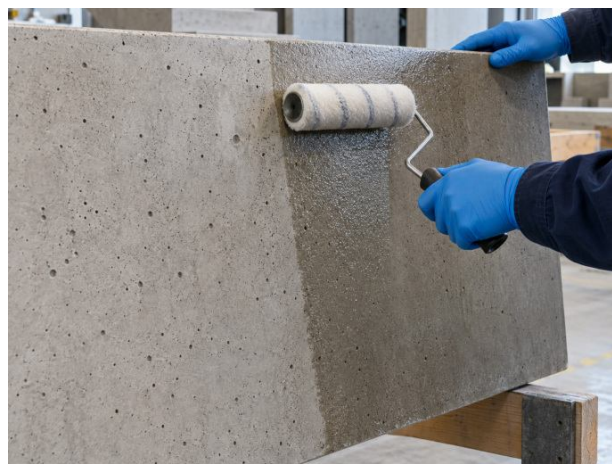
Régulation du fond avant lasure architectonique.
