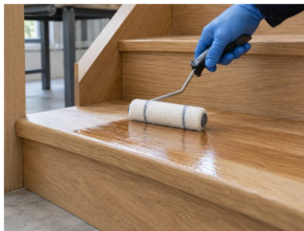
Vitrification de parquet et pièces d'escalier.
