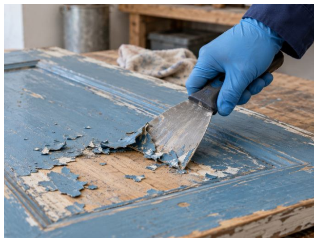
Remise à nu d'une menuiserie revêtue.
