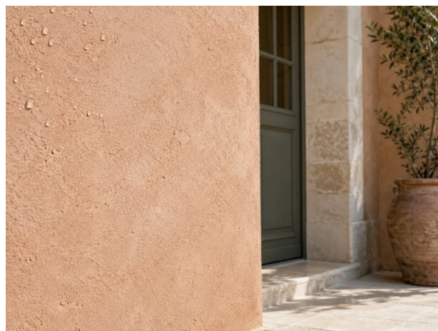
Protection d'un parement à la chaux.
