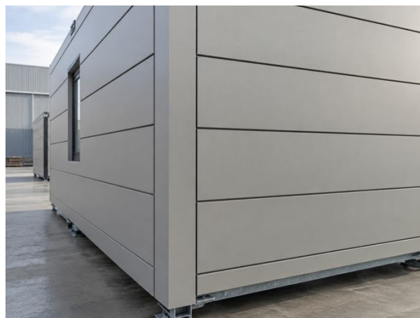
Finition aqueuse sur cassettes de bardage préparées.
