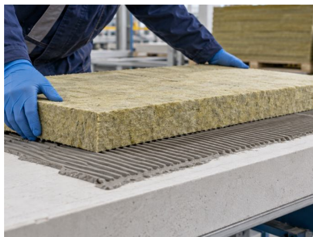
Collage d'un isolant sur panneau de module.
