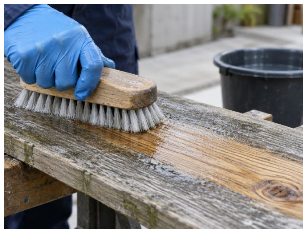
Remise en état d'une lame de bois grisée.
