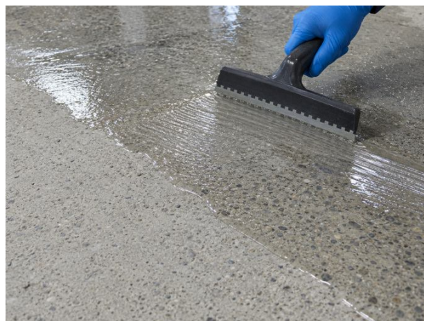
Primaire époxy sans solvant sur béton préparé mécaniquement.
